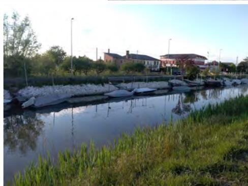
**A lato.** Il canale Siloncello con le sponde difese da una massicciata di sassi. La fragile e preziosa fascia di vita selvatica anfibia insediata sul battente dell'onda del corso d'acqua viene così distrutta irrimediabilmente.
