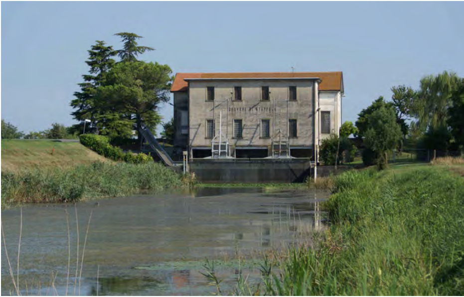
A lato. L'idrovora di Staffolo (Torre di Mosto, VE).
