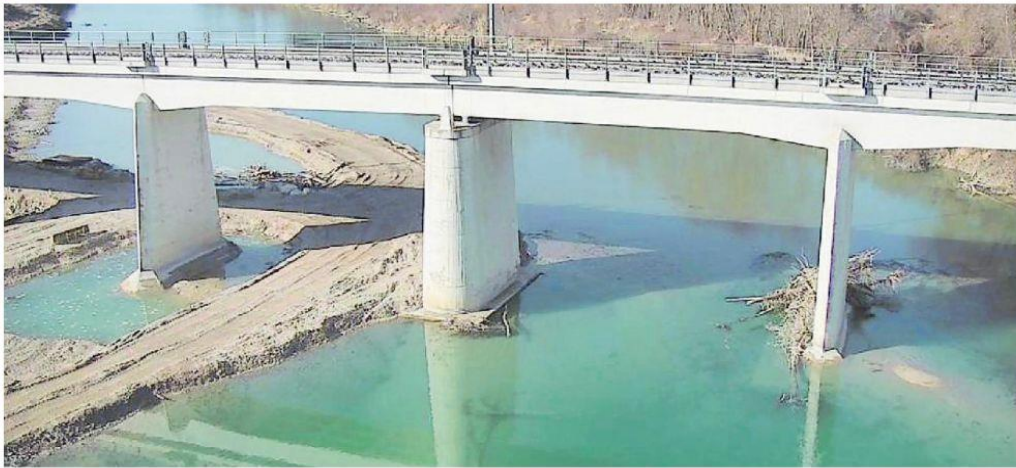
Il Piave a Ponte di Piave: proprio in questi giorni Rfi ha in corso lavori di consolidamento dei piloni e rimozione di detriti alla loro base
